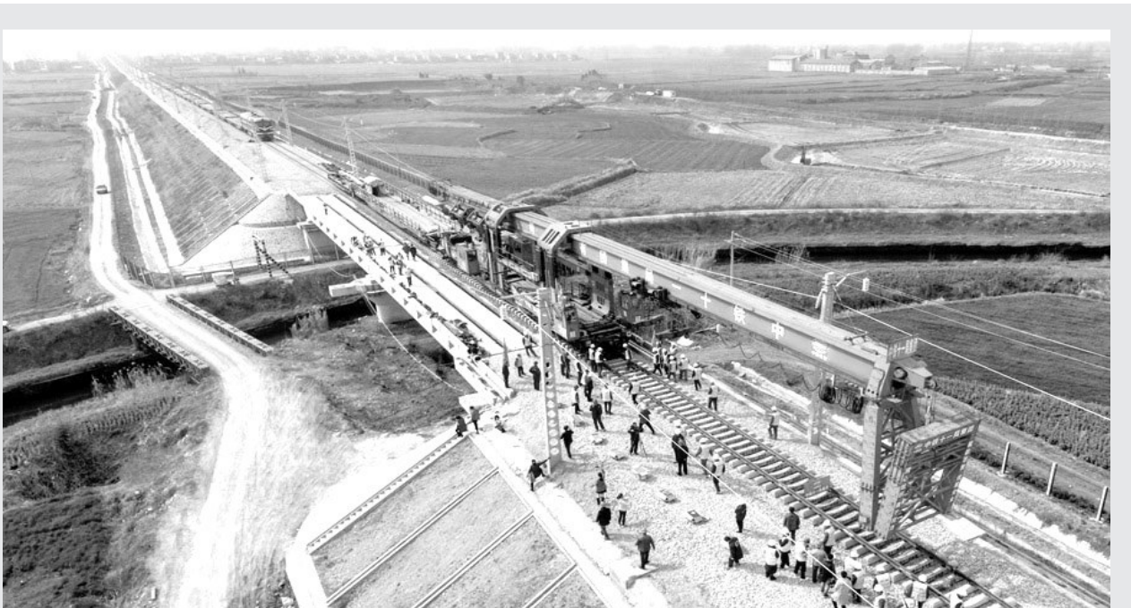
3月11日，随着湖北省宜昌市小城镇蒙华铁路蛮河特大桥—组铁轨铺设到位，由中国铁建所属中铁十一局承建的湖北荆门至襄阳区间线路接轨顺利完成，标志着蒙华铁路湖北段全线铺轨贯通，也为蒙华铁路今年10月1日通车奠定基础。蒙华铁路全长1800多公里，北起内蒙古浩勒报吉站，终点到达江西省吉安市。其中，蒙华铁路湖北段全长330.6公里，从河南南阳进入湖北，途经襄阳、荆门、荆州市。图为无人机拍摄的蒙华铁路蛮河特大桥铺轨作业现场。 杨东 摄影报道
