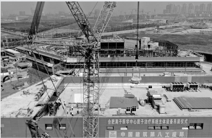
4月8日,由中建八局上海公司承建的安徽合肥离子医学中心成功进行质子治疗系统主体设备吊装。
