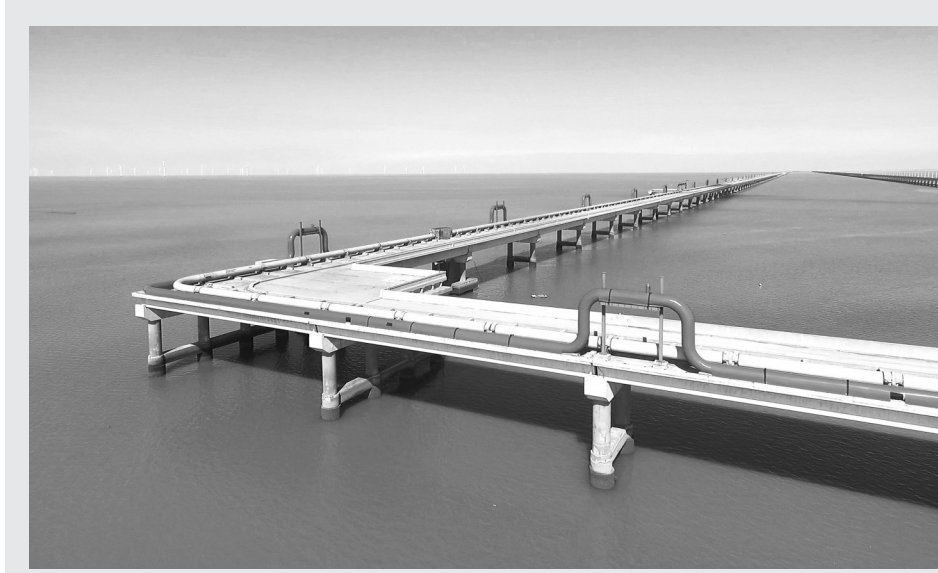
近日,由中交二航局建设的南通洋口港PPP项目南侧码头区液体化工码头二期工程完工。
