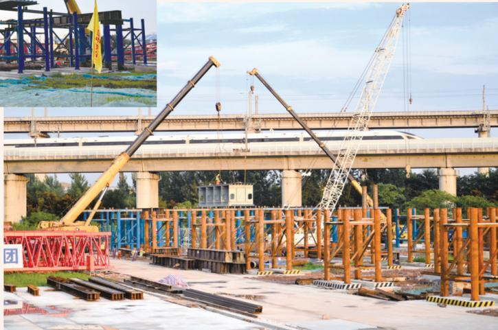
近日,由中铁四局南京南部新城一经理部承担施工任务的南京南部新城承天大道跨外秦淮河特大桥首节钢箱梁按照节点工期计划顺利安装就位,这标志着该特大桥全面进入主桥上部结构施工阶段。
