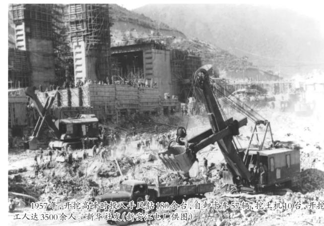
1957年,开挖高峰时投入导风筒180余台,自制吊车57辆,挖土机10台,开挖工人达3500余人。新华社(新安江电厂供图)
