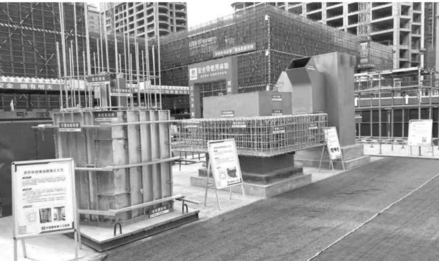
优势,因此经过短期培训后的工人,每天可安装30平方米左右,每一层结构浇筑中,将木模需要5~6天缩短为3~4天。质量上,铝模的构件尺寸偏差值均在毫米之间,有效改善了木模误差大、易“跑模”、易错台等问题。
