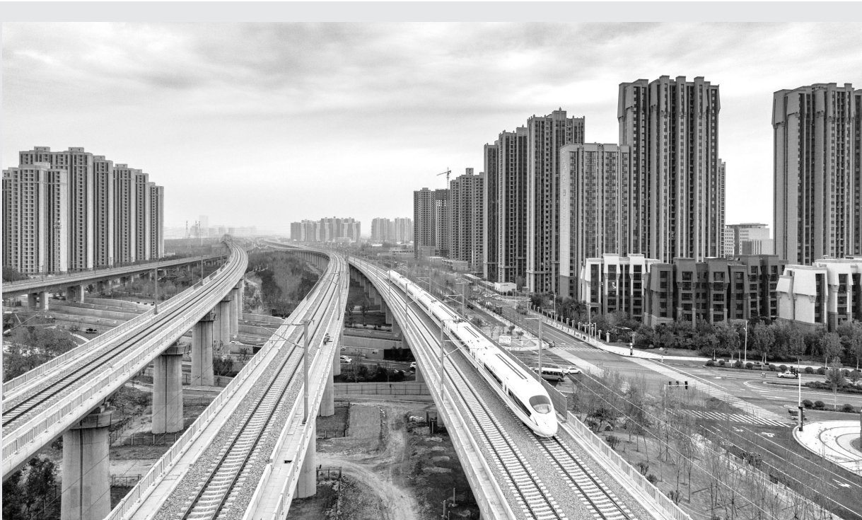
日前,郑渝高铁郑州至襄阳段正式开通运营。由中交二航局承建的郑渝高铁站前1标段,位于郑州东站至郑州南站之间,线路全长34.739千米,其中正线长28.592千米,郑渝高铁郑襄段是西南连接中原的主要客运快速通道,也是河南省“米”字形高铁网中的重要一“撇”。
