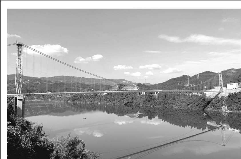
近日，由中铁十八局建安公司承建的国内跨度和荷载最大的管道悬索桥——重庆南川水江至涪陵白涛天然气管道乌江悬索桥具备通气投产条件。该桥是国内首个大型页岩气田——涪陵页岩气田开发配套的重点工程，横跨乌江，全长467.8米，主跨长355米，总荷载超过1008吨，位居国内同类管道悬索桥之首。 伍振 摄影报道
