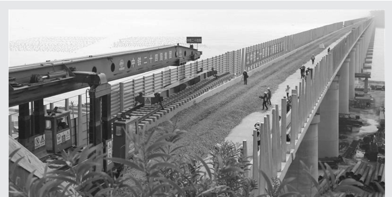
12月22日10时15分，随着中铁二十四局铺轨工程车将一对轨排稳稳落在福平铁路平潭海峡公铁两用大桥路基上，标志着世界最长、我国第一座跨海峡公铁两用大桥开始铺轨施工，为福平铁路的建成通车打下了坚实基础。 平潭海峡公铁两用大桥是连接福州和平潭岛的重要通道，大桥全长16.34公里，起于福州市长乐区松下镇，从苏澳镇上平潭岛。大桥下层设计为时速200公里的双线Ⅰ级铁路，上层设计为时速100公里的双向六车道高速公路。 中铁二十四局承建福平铁路FPZQ-2标段工程施工任务外，还负责福平铁路全线铺轨、架梁作业，由于福平铁路属于双线铁路，全线需新铺轨道171.44公里、架设T梁1036孔。 平潭海峡公铁两用大桥施工区域与百慕大三角、好望角并称世界3大风区，是我国乃至世界上目前施工难度最大的桥梁之一。 文雄/文 龙敏/图
