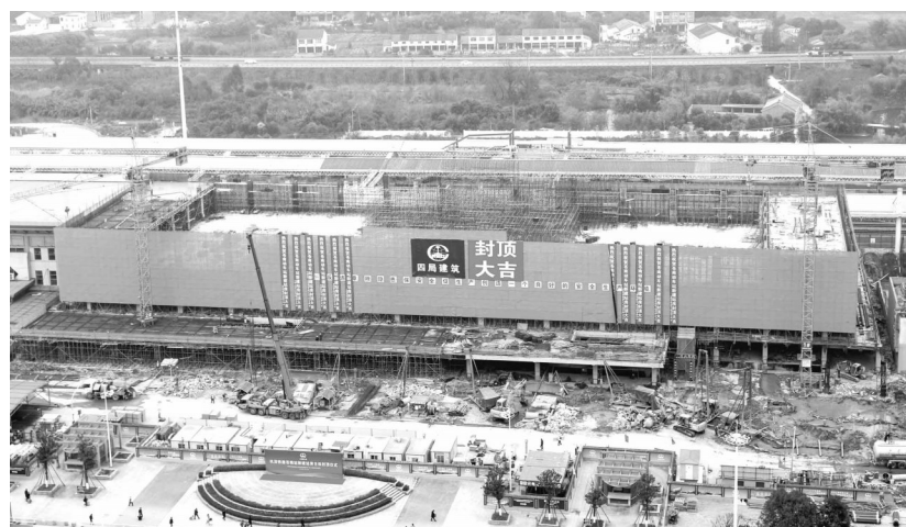
近日, 由中铁四局建筑公司承建的杭深铁路苍南站改扩建工程新建站房主体结构封顶。 苍南站是全国首个动车直通北京的县级始发站, 改扩建工程包括新增到发线1条、增设站台1座、新建8米宽跨线天桥1座、扩建站房规模等。 改扩建后, 苍南站建筑面积将由现在的3065平方米扩容到26993平方米。 通讯员 张东晓 张飞 摄影报道
