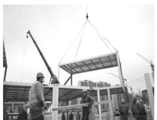
中国一冶承建的湖北鄂州雷山医院项目现场，3000余人、300余台大型机械正在同步施工。鄂州雷山医院分两期建设，一期建筑面积3500平方米，由228个集装箱组成，有52个病房，100个床位；二期建筑面积28000平方米，由1418个集装箱组成，有336个病房，670张床位。
