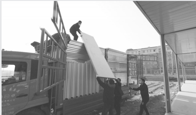
施工ZJTLZQSG-1标,正线长度33.2公里。目前已开始项目部驻地建设。
