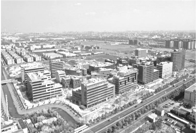
由上海二十冶华中分公司承建的上海新材料创新基地南区钢结构工程,目前进入最后的交工验收阶段。
