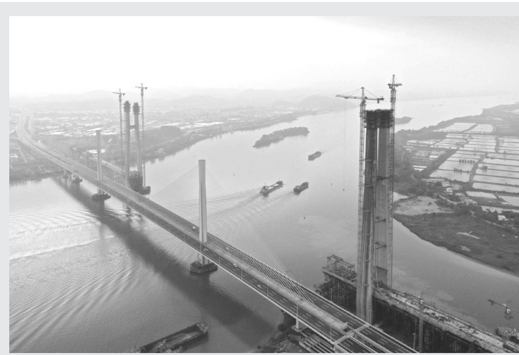
3月18日,中铁十一局承建的粤港澳大湾区重点工程——广州南沙港铁路跨西江斜拉桥主塔封顶,大桥整体建设取得重要进展。该桥位于广东佛山市和江门市交界处,全长1117.5米。 通讯员 刘大伟 摄影报道
