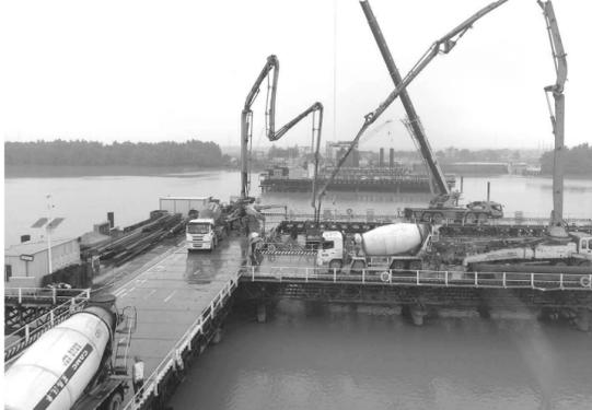
4月1日5:30分，中铁广州局桥梁公司南沙大岗项目上横沥大桥10号墩主墩围堰封底混凝土顺利浇筑完成。这是节后复工以来该项目完成的首个重要节点。10号主墩钢围堰顺利封底，为后续承台及主墩施工打下了坚实的基础，项目生产按下“快进键”。
