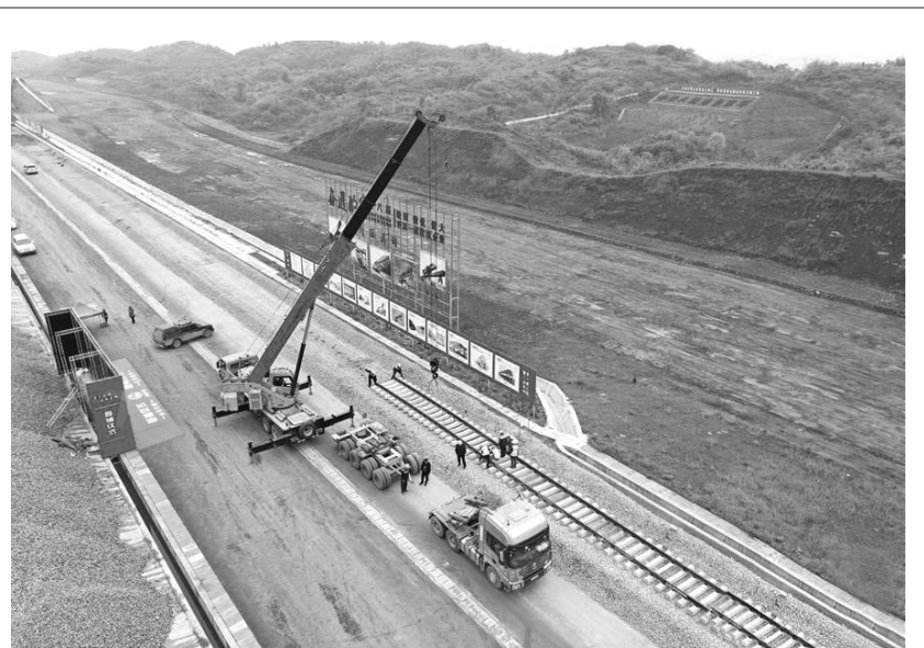
4月2日,首组12.5米的轨排稳稳落在龙盛车站路基上,标志着重庆铁路枢纽东环线正式进入铺轨施工阶段。重庆铁路枢纽东环线由中铁八局二公司重庆东环项目部承建,正线线路全长约158公里。开通后将对加快沿线城市建设、促进区域经济增长等具有重要意义。唐奕 摄影报道
