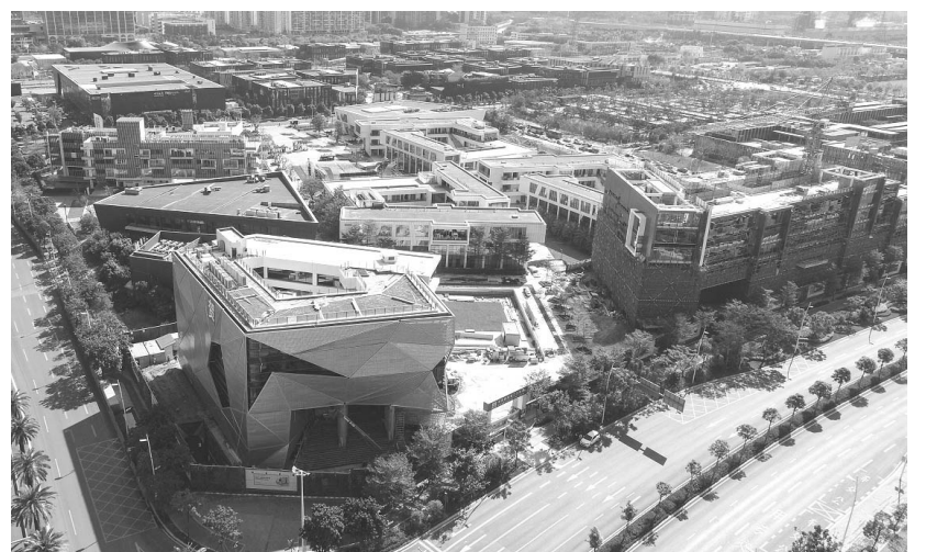
近日,由中建二局二公司承建的深圳市前海深港青年梦工场西区项目正式复工。该项目位于深圳市前海合作区前湾一路与梦海大道交会处,作为前海加快建设粤港澳大湾区青年创新创业重大平台的标志性项目,梦工场西区项目建成后将进一步扩展梦工场整体服务空间,提升整体服务功能,助力深港青年筑梦圆梦。通讯员 秦闯 摄影报道
