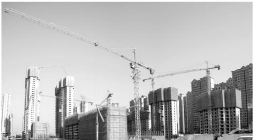
红光村城中村改造DK4-A(世茂璀璨倾城)一期建设项目,位于西安市未央区御井路与汉渠南路东北角,地处未央区经济发展核心走廊位置,于国际港务区、浐灞生态区,经开行政区三区交汇处,总建筑面积约24万平方米,共16栋单体建筑,结构类型为框架剪力墙结构。
