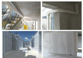
施工用水对其它工序造成污染，在N-2层顶层设置楼层截水系统。
