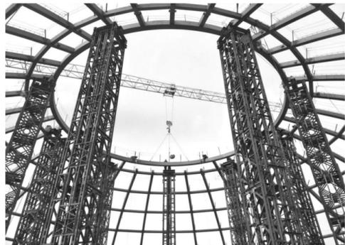
的巨龙，在空中划出一条优美的弧线，将整个建筑群连为一体，和一旁的龙珠大厦交相辉映，构成“龙颌珠”的特别意象。这条面积全国第一的天幕高36米，断面宽度由36.5米渐变至10米。主体为桁架加网架结构，顶部为双曲面幕墙系统，底部为全景式LED显示屏和景观灯光带，涉及钢结构、装饰、机电安装等十余个专业，仅各部分连接处的螺栓球节点就多达一万多个，结构复杂，安装精度要求极高。根据网架结构特点，天幕所有杆件和螺栓球节点均不允许焊接，这也是曾友明将天幕的建造安装比喻成“空中绣画”的主要原因。
