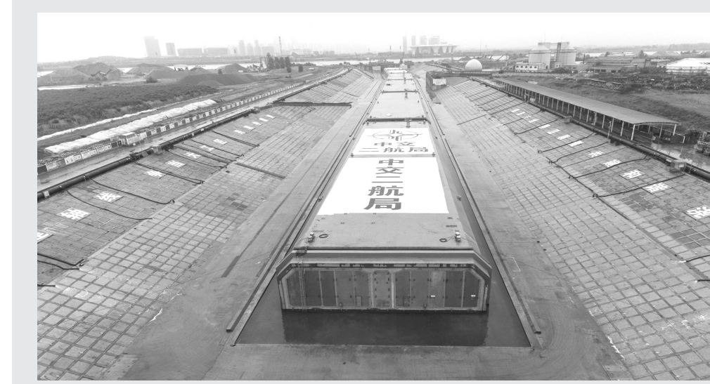
后进行干坞排水,浇筑压舱混凝土,确保沉管干舷安全可控,为下一步的浮运安装做准备。东西轴线鱼梁洲段全长5.4公里,是华中地区首条内河沉管隧道,也是国内整体建设规模最大的内河沉管隧道。建成后快速推进襄阳市“一心四城”城市总体规划实施,进一步提升襄阳“七省通衢”交通枢纽作用。
