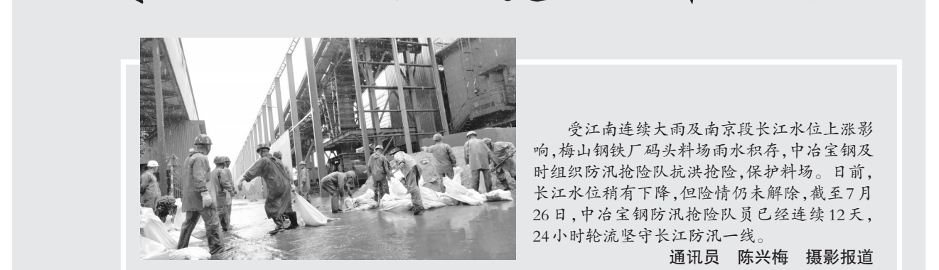
受江南连续大雨及南京段长江水位上涨影响,梅山钢铁厂码头料场雨水积存,中冶宝钢及时组织防汛抢险队抗洪抢险,保护料场。日前,长江水位稍有下降,但险情仍未解除,截至7月26日,中冶宝钢防汛抢险队员已经连续12天,24小时轮流坚守长江防汛一线。 通讯员 陈兴梅 摄影报道
