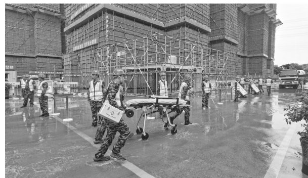
7月29日,江苏省苏州市相城区建筑施工安全生产警示教育现场会暨工程质量安全标准化观摩活动在中建八局第二建设有限公司承建的苏地2017-WG-04号地块项目举办。活动全程视频直播,设置300多个直播分会场,在线观看观众近5000人。安全生产警示教育现场会和观摩活动以“消除事故隐患、筑牢安全防线”为主题,设立了教育会场区、演练救援区、安全体验区、样板展示区、VR体验区、智慧工地展示区、绿色施工展示区等七个展区,展示了项目安全生产亮点和风采。该项目位于苏州市相城区,总建筑面积约38.9万平方米,包括20栋高层住宅和19栋多层住宅。目前北区14栋高层住宅和7栋多层住宅即将全部竣工验收,南区高层住宅全部封顶,各专业工序有序穿插。通讯员 李孟哲 杨婕 摄影报道
