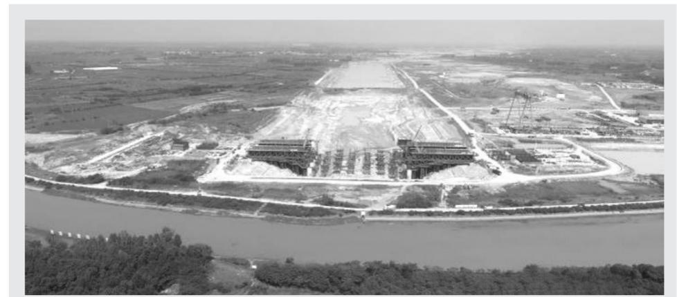
由中国铁建大桥局承建的引江济淮工程淮河总干渠钢渡槽施工现场，一件重达76吨的钢渡槽拱弦C11构件稳稳落下。
