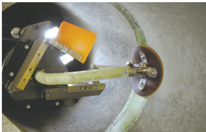
▲管道修复机器人工作模拟图
