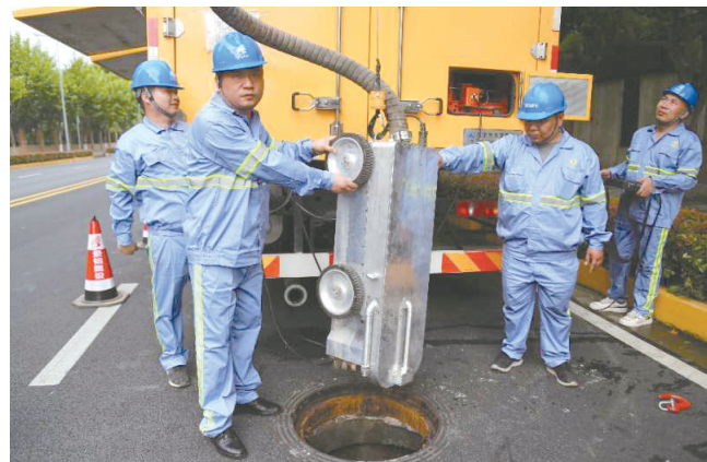
▲公司董事长潘国乔(左二)深入一线操作管道机器人
