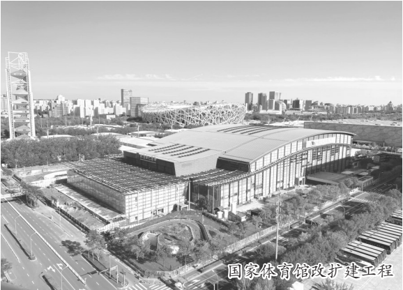
国家体育馆改扩建工程
