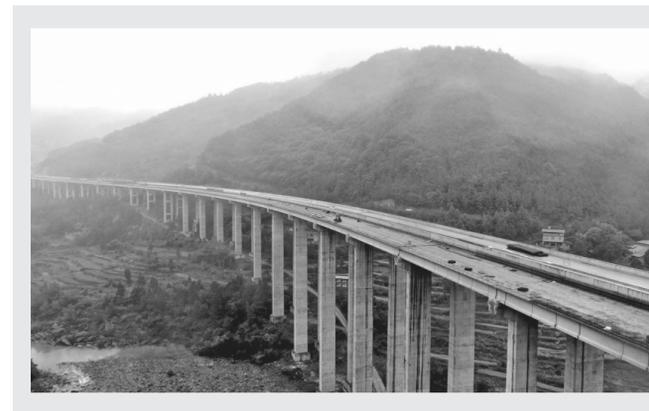
近日,随着最后一片T梁架设完成,由中国能建葛洲坝三峡建设公司承建的巴万高速公路最长大桥——陈家河特大桥全幅贯通。
