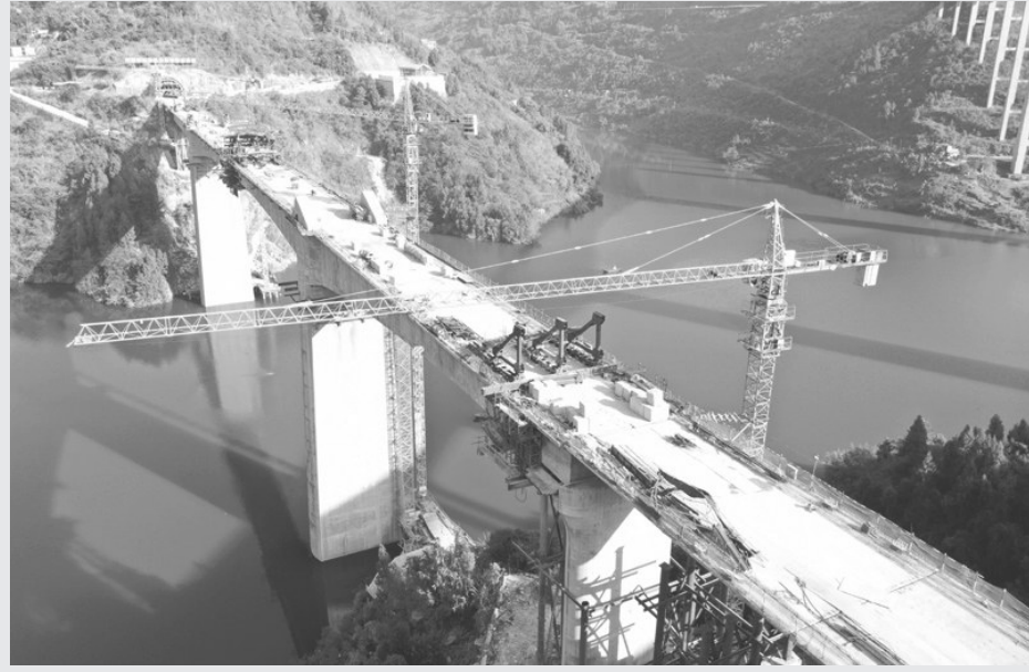
11月8日,郑万高铁重庆段全线控制性工程汤溪河双线大桥合龙。汤溪河双线大桥位于重庆市云阳县云阳镇境内,桥梁全长472.7米,为双线高速铁路大桥。郑万高铁全长818公里,是西南地区连接华中与华北的主要高速铁路通道。唐奕 摄影报道
