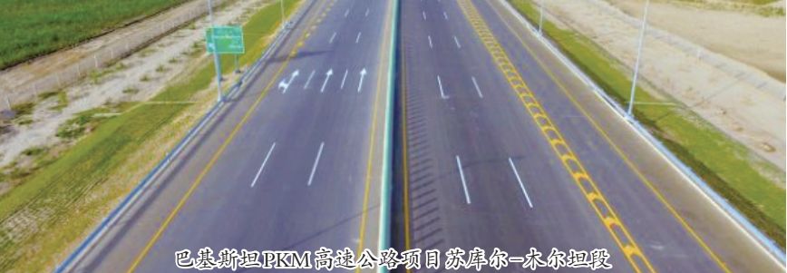
巴基斯坦PKM高速公路项目苏丹库-米尔坦段
