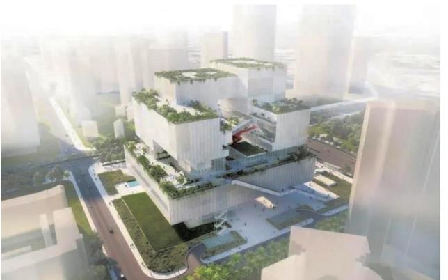
最近，中建科工中标深圳市宝安区公共文化艺术中心施工总承包工程，中标额约10.5亿元。该项目总建筑面积9.21万平方米，建筑高99.9米，其中地下3层，地上12层，含博物馆、美术馆、艺术馆三大功能场馆及相关配套用房等，是深圳市及宝安区的重点项目。项目主体结构为全钢结构，造型复杂，主要特点有大跨度、大悬挑、装配式等。该项目地理位置优越，坐落于深圳宝安中心区创业路与新湖路交汇处，采用“三馆合一”(博物馆、艺术馆、美术馆)形式建设，是新时代先行示范区具有国际影响力的西部岸线文化地标。项目建成后，将填补宝安区大型博物馆、艺术馆、美术馆的空白，极大地提升宝安区城市品质，增强宝安区文化底蕴。 彭阳
