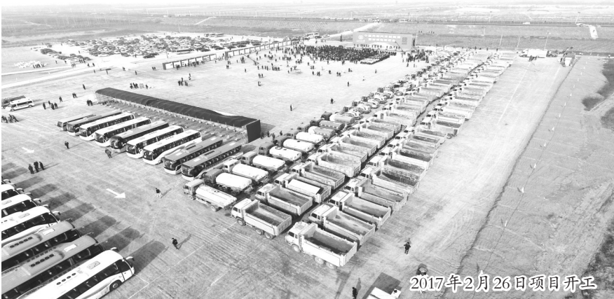
2017年2月26日项目开工
