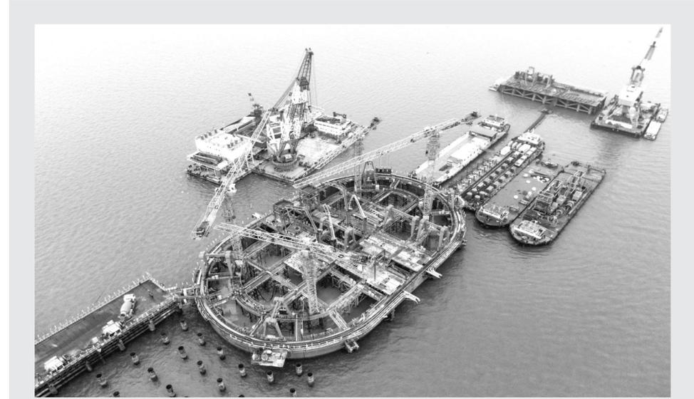
3月9日,长江上首座集高速公路、城际铁路、一级公路“三位一体”的过江通道——常泰长江大桥历时39天,完成5号主墩钢沉井封底混凝土浇筑施工,标志着沉井基础水下施工全部完成,即将进入水上承台及塔柱施工。
