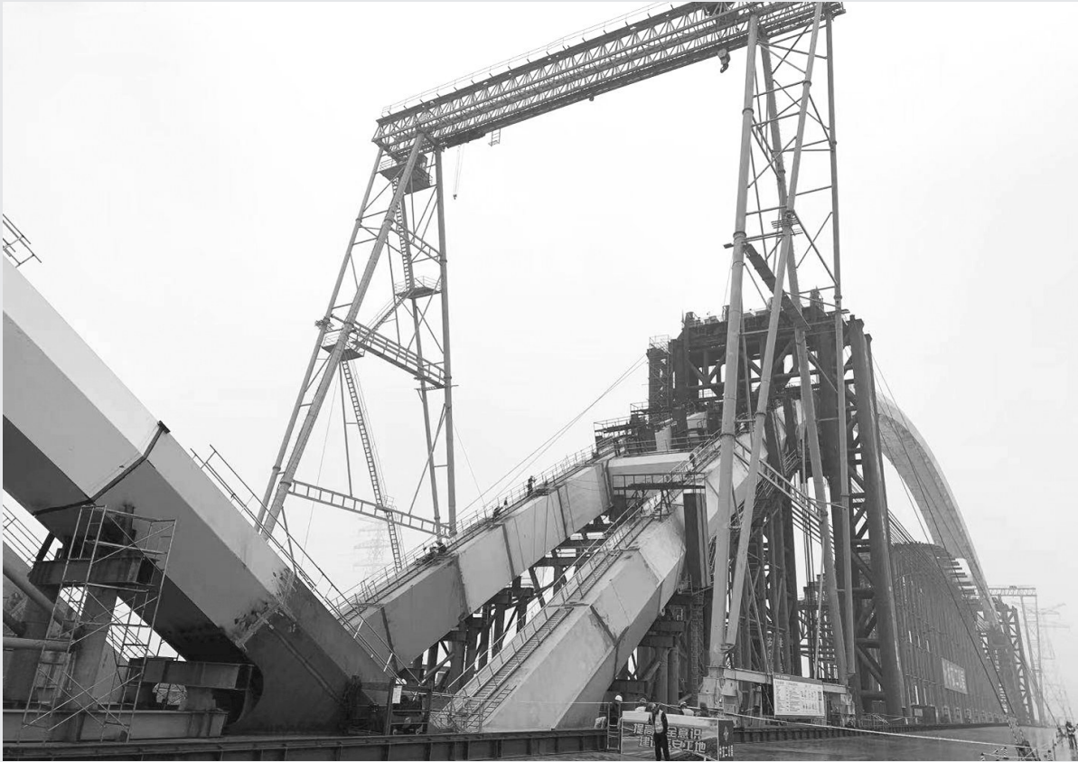
3月15日,齐鲁黄河大桥主跨420米拱肋实现合龙。大桥为下承式网架系杆拱桥,按照双向八车道设计,线路全长6742米,主桥长度1170米,主跨径达420米、宽60.7米,是黄河上的最大拱桥,创造了世界上同类型桥梁最大跨径、最大梁宽、最高顶应力拉索的纪录。
