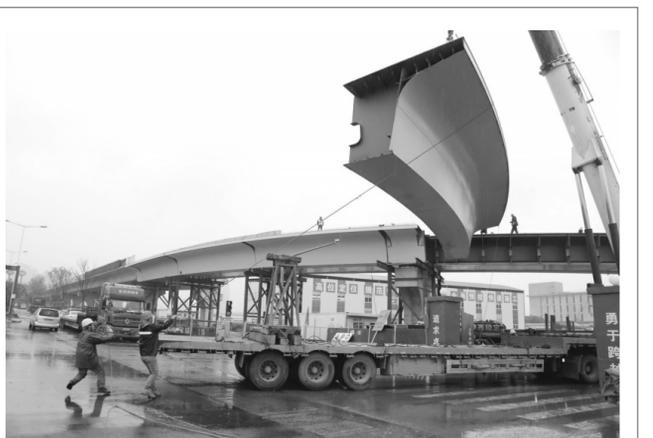
4月25日,在中铁电气化局铁路工程公司西安北站枢纽工程桥梁工地,随着最后一根钢箱梁吊装合龙,全长16.1公里的高架桥梁主体结构贯通。
