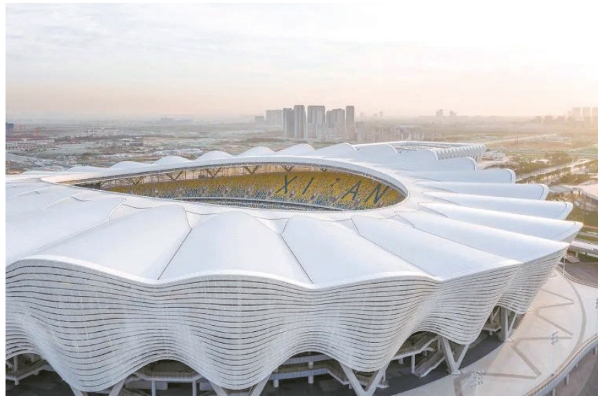
“2020年度全球最佳体育场”评审团,亦大篇幅对这个主体育场建设过程进行介绍:“仅用4个月就完成15万平方米主体结构施工,3个月完成102万吨钢结构吊装任务,一个半月完成8828块看台板吊装作业,90天完成5万平方米金属屋面,75天完成2.4万平方米铝板幕墙,较同类体育场建设效率提高近30%。”
