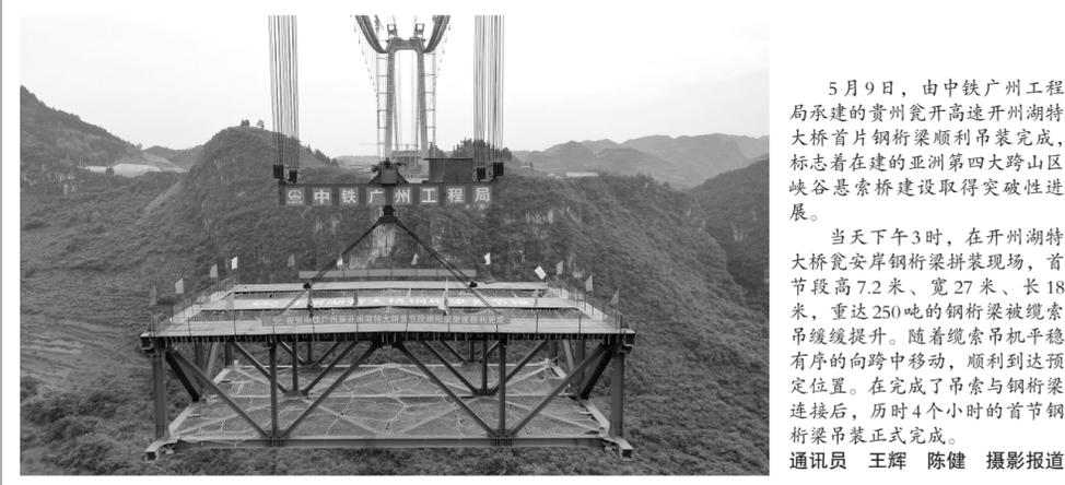
5月9日,由中铁广州工程局承建的贵州瓮开高速开州湖特大桥首片钢桁梁顺利吊装完成,标志着在建的亚洲第四大跨山区峡谷悬索桥建设取得突破性进展。
