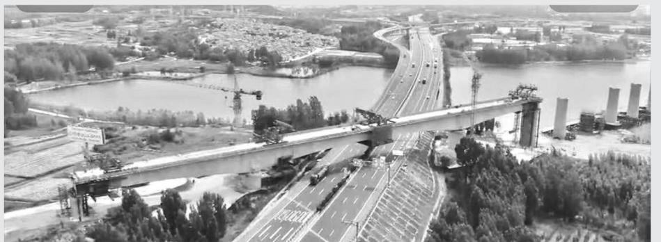
5月26日,由中铁二十二局四公司施工的济莱高铁孝义水库特大桥120米连续桥梁合龙,这也是济莱高铁首座桥梁贯通工程。
