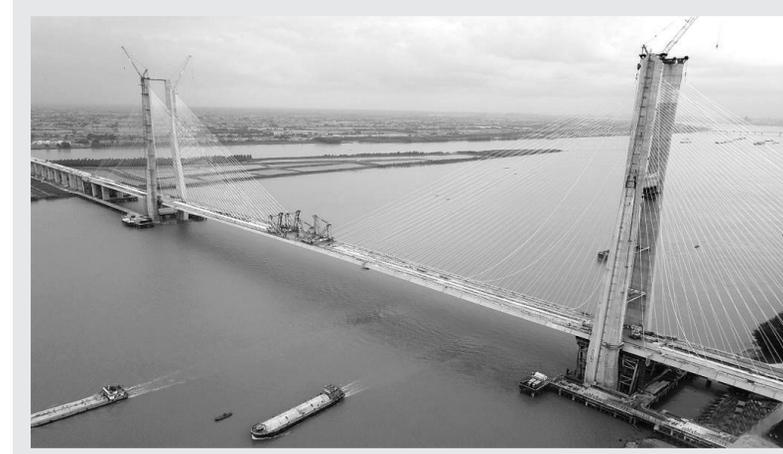
6月3日,安九铁路鳊鱼洲长江大桥合龙。鳊鱼洲长江大桥北侧位于湖北黄梅县,南侧位于江西九江市,按照两线高铁及两线预留客货共线标准建设,高铁时速350公里,预留客货线时速200公里。
