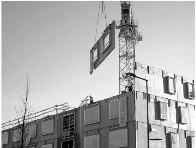
一栋楼，阳台板、楼梯、内墙、外墙等都是事先在工厂加工好，运到施工现场后再组接在一起，盖房子就像生产汽车……装配式建筑是建筑产业转型升级的重要方向。2020年，山西省新开工装配式建筑822.52万平方米，占到城镇新建建筑面积比例的18.7%。据悉，今年起，山西省将加快装配式建筑的发展步伐，对符合装配式建筑实施条件的项目及时跟踪服务指导，严格落实装配式建
