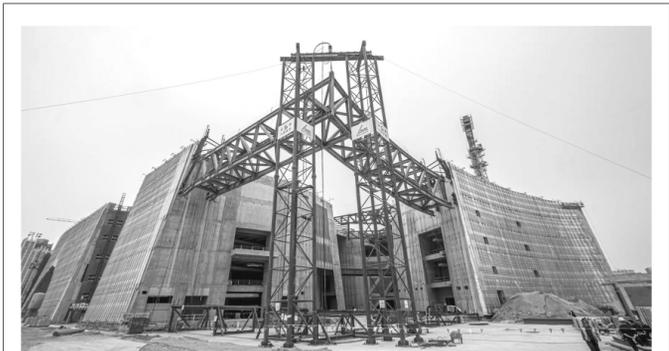
近日,陕西省榆林市“三馆”项目施工迎来重大突破。工程承建方中建九局集团历时30个小时完成了280吨钢结构悬挑桁架的整体提升,提升高度30.5米。
