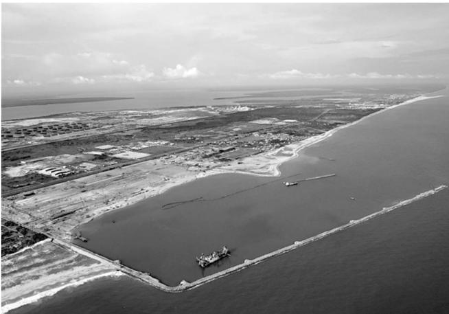
尼日利亚莱基港，大西洋海水在防波堤外波涛汹涌，堤内却平静祥和。4月29日，莱基港实现融资首放款；5月18日，1号泊位所有桩基施工完毕；5月24日，绞吸挖泥船“新海豚2轮”开始吹填作业——从2020年6月开工至今，由中国港湾工程有限责任公司（中国港湾）控股的莱基港投资、建设、运营项目稳扎稳打，破除新冠肺炎疫情干扰，推动项目整体建设进度不断提前，达到了54.71%，预计于2023年正式投入运营。
