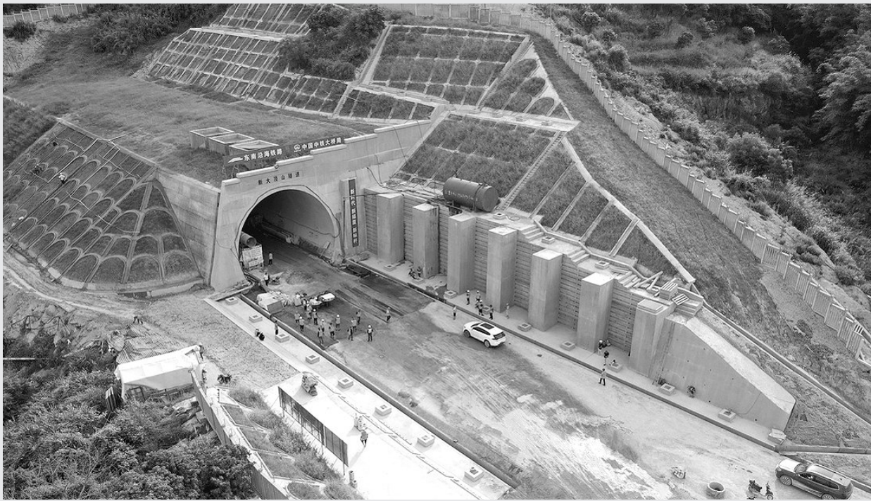
7月12日,由中国中铁大桥局承建的新建福厦铁路新大顶山隧道举行顺利贯通仪式。至此,新建福厦铁路正线隧道全部贯通。 新建福厦铁路是我国首条跨海高铁,设计时速350公里。
