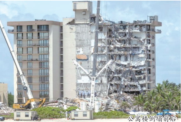
公寓楼倒塌前后
