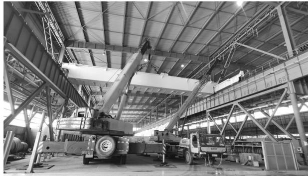
近日,中冶宝钢仅用15小时完成梅钢冷轧厚规格酸洗纵切线新增一台38吨行车安装项目。
