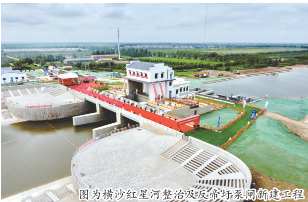
图为横沙红星河整治及反帝圩泵站新建工程
