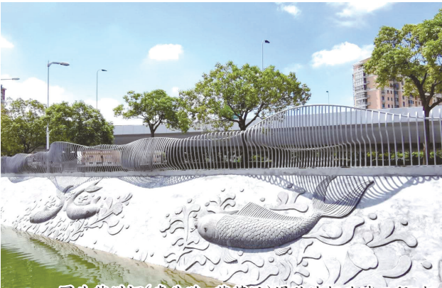
图为苏州河(真北路-藻浜浜)堤防达标改造工程I标
