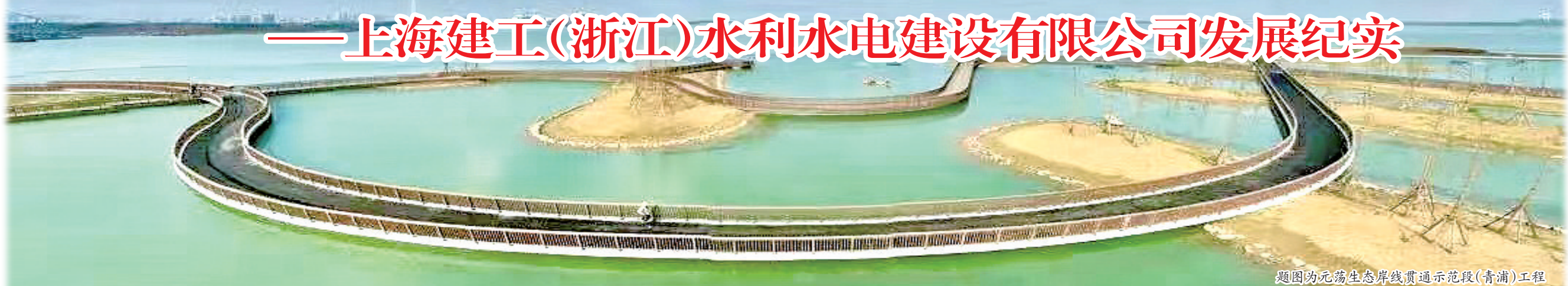
图为元荡生态岸线贯通示范段(青浦)工程
