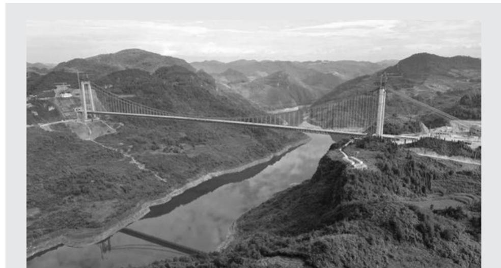
8月17日10时,随着最后一节段钢桁梁精准定位到安装点,主跨1100米的开州湖特大桥成功合龙。开州湖特大桥是贵州境内瓮开高速公路唯一的控制性工程,全长1257米、主跨1100米,桥面距湖面250多米,是亚洲第四大山区跨越峡谷类型悬索桥。全桥共需吊装76根钢桁梁,通过荡移调整端梁的方式确保主桥顺利合龙。此次吊装的合龙梁重达240余吨,采用起重能力为250吨的缆索吊机进行吊装。
