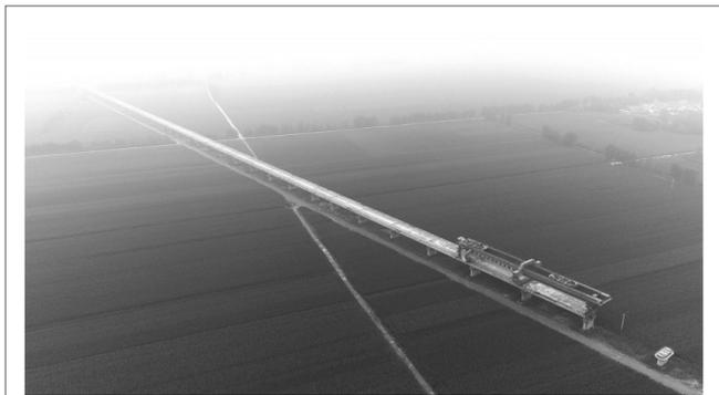
近日,中铁上海局郑济铁路项目山东段一标段完成第435孔大型箱梁架设。至此项目架设箱梁完成过半,为下一步无砟轨道施工奠定基础。
