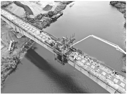
9月13日,由中铁上海工程局承建的南通港铁路跨新江海河特大桥连续梁合龙。
