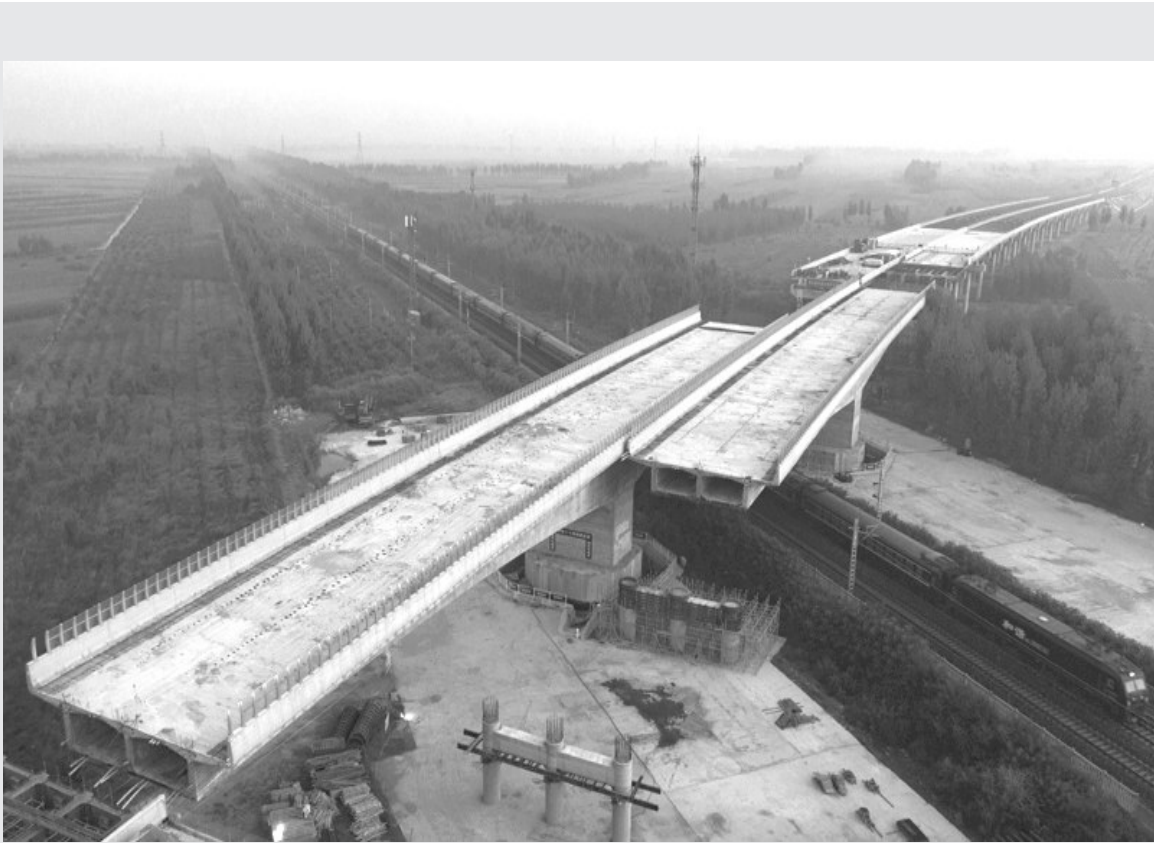
9月10日,河北省滦州市境内的迁(安)曹(妃甸)高速公路跨京哈铁路双桥转体成功,与高速主路实现精准对接。
