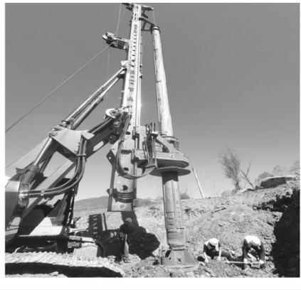
9月15日10时18分,伴随着旋挖钻机的轰鸣声,中铁二十三局集团承建的沈阳至白河高速铁路吉林段TJ-6标段湾沟特大桥首桩开钻,拉开了该标段桥梁施工序幕。
