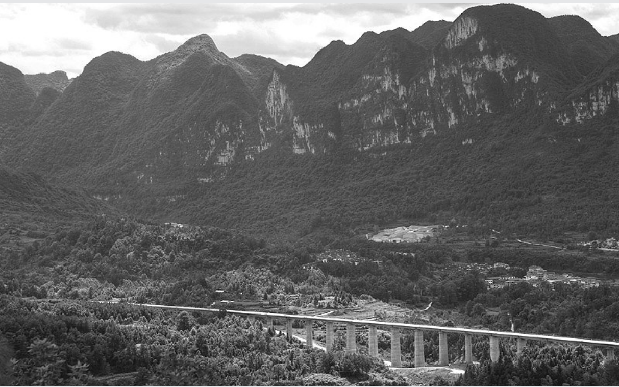
9月16日,由中铁十八局集团承建的贵南高铁捞村双线特大桥顺利合龙。捞村双线特大桥位于贵州省荔波县境内,全桥长约2138米,最高墩达49米。 贵南高铁是我国“八纵八横”高速铁路主通道包头至海口通道的重要组成部分,设计时速350公里。 刘续 摄影报道
