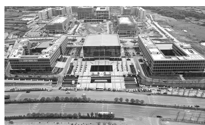
为迎接VR大会,国庆期间,江西建工一建南昌国家职业教育虚拟仿真实训基地项目安排管理人员全部在岗,两班倒日夜加班完善2#楼二层墙地面装饰,3#楼一层室内修繕,西区室外景观绿化、石材返修及清理等工作,全力以赴既定工期任务。江西建工一建
