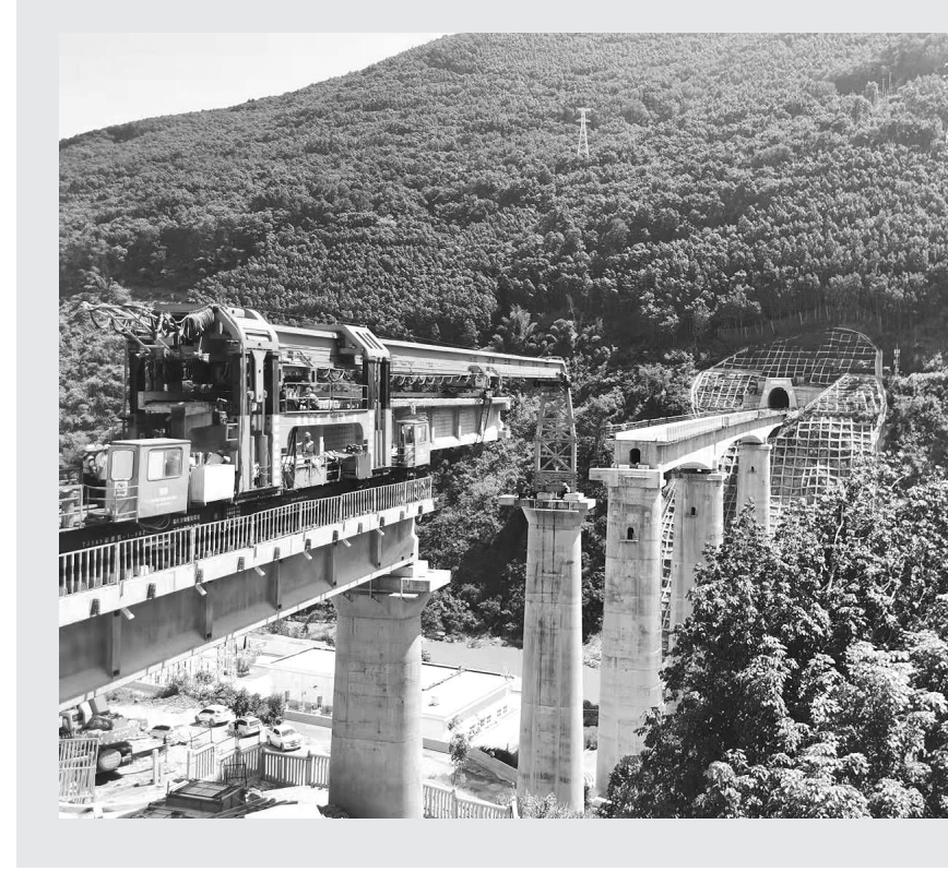
10月7日,中老铁路国内玉磨段,中铁一局项目部员工放弃了节日休息,他们在工期紧、任务重、质量要求高的情况下,精心组织,合理安排,铺轨架桥不断向前延伸。图为工人正操作架桥机架设西双版纳傣族自治州景洪市境内的南班河大桥。通信员 刘顺良 摄影报道
