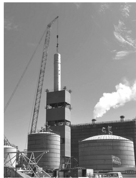
10月20日, 浙江省工业设备安装集团有限公司二分和空分工程分公司承建的浙江巴陵恒逸己内酰胺有限责任公司传统煤制氢提标改造及副产品合成氨联合装置57000标准立方米/小时空分装置项目冷箱顺利结项。 自8月23日举行开工仪式以来, 项目部克服施工场地紧张、土建交叉作业等不利因素, 保质保量完成每个重要节点任务。 通讯员 李鹏 摄影报道
