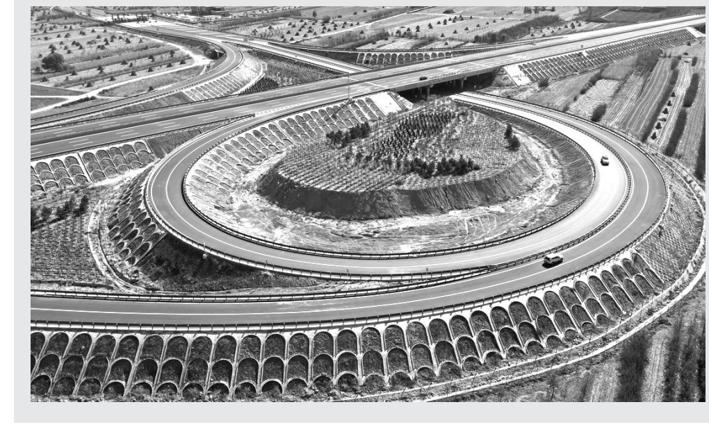
10月22日,河北迁曹(迁安—曹妃甸)高速公路京哈高速至雷庄互通段建成通车,标志着迁曹高速公路全线通车。迁曹高速公路项目全长约92公里,是京津冀交通一体化建设的重要交通项目。
