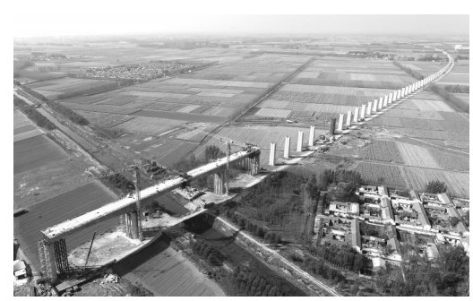
太子城西院落遗址展厅保护性设施建筑面积约4600平方米,为南北方向的矩形院落。保护性设施建筑主体跨度98米——纪念本届冬奥会距离第一届奥运会98年的历史(1924年—2022年)宽47米,保护性设施建筑主体面阔24开间——象征在此举行的第24届北京—张家口冬季奥林匹克运动会。院内共有五处
