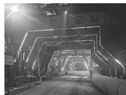
由上海宝冶集团施工的浙江杭州富阳320国道至富阳大桥连接线大盈山隧道工程是富阳“十四五”交通规划重点项目,更是杭州亚运会重要交通配套工程。隧道全长2328米,双向六车道,局部双向八车道,最大断面净宽17.75米,断面达二百多平米,比一般隧道要大一倍多。隧道进口段V级围岩采用50米的超长管棚初期支护,在国内隧道施工中属罕见。
